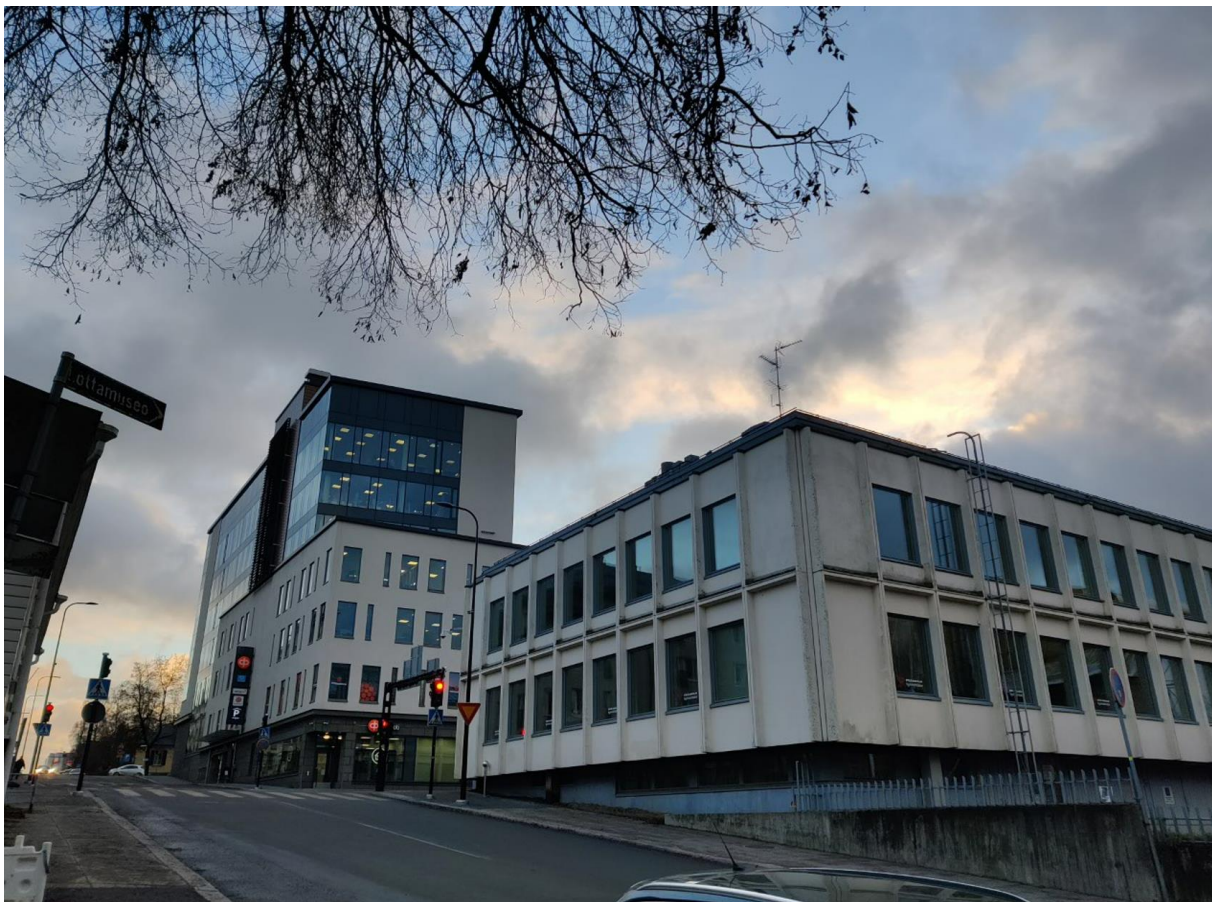
Kuva 17. Kuvan etuosassa suunnittelualueen eteläpuolella sijaitseva ns. virastotalo, jonka takana näkyy v.2016 rakennettu Osuuspankin konttori.
