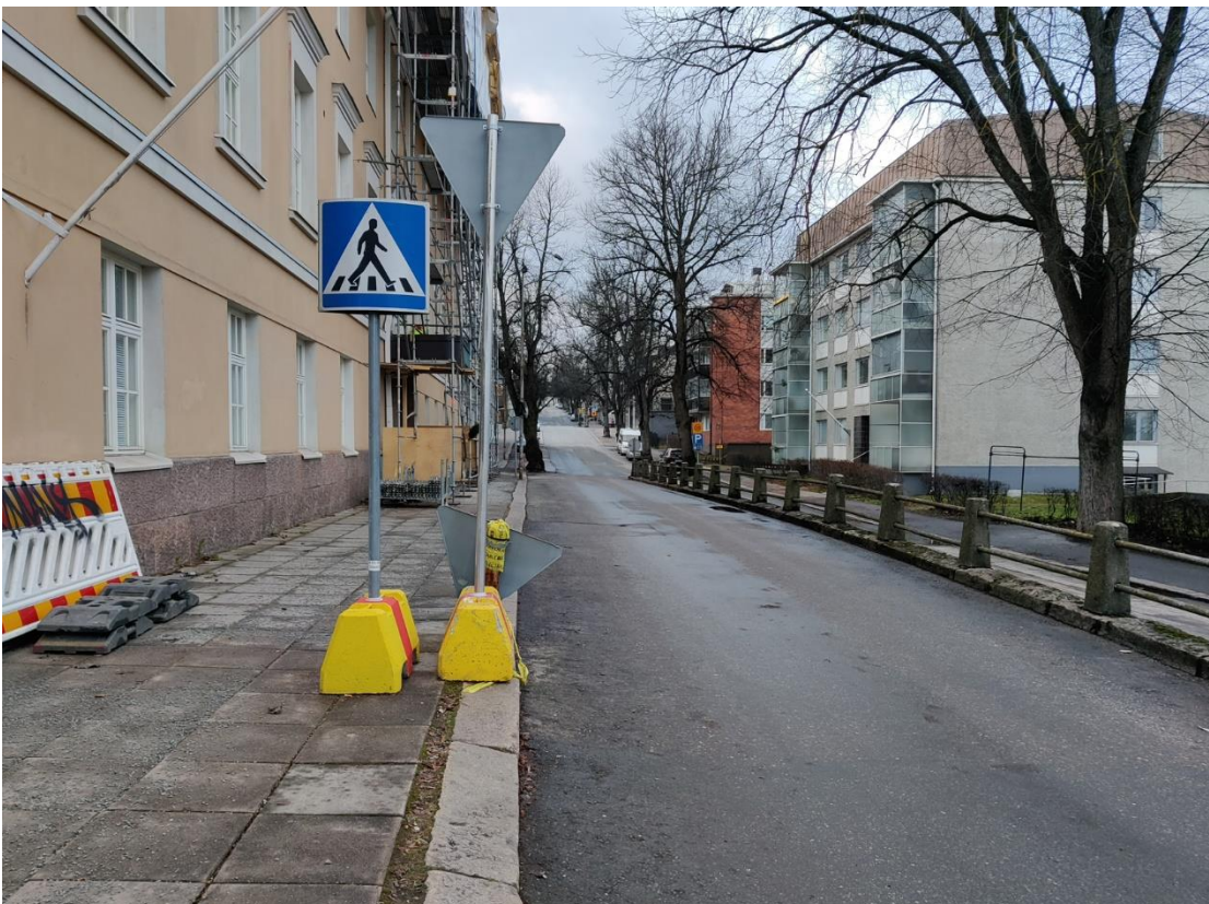
Kuva 23. Raastuvankatu kuvattuna suunnittelualan kohdalta länteen päin.
