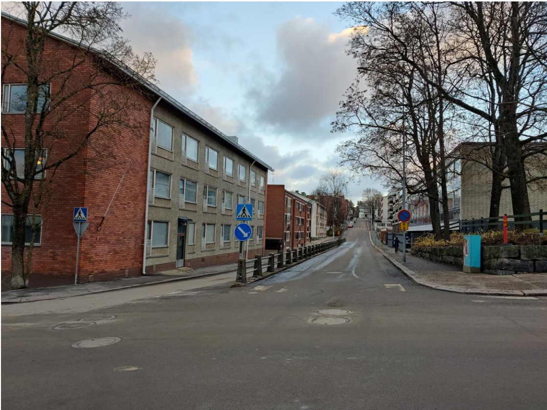
Kuva 22. Kirkkokadun ja Raastuvankadun risteys itään päin kuvattuna. Kuvassa näkyy, kuinka Raastuvankatu kulkee kahdessa eri tasossa ja ajoradan kaistat on jaettu tukimuurin avulla eri korkotasolle.
